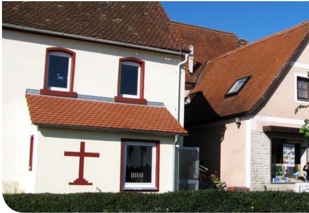
Gemeindehaus der EFG Feuchtwangen
